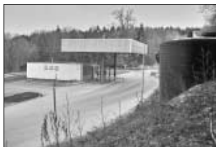
Die Annahmestelle der Deponie Reesberg in Kirchlengern
