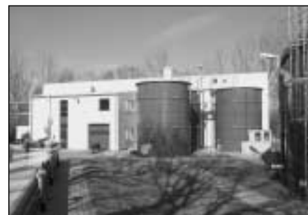
Die Sickerwasserbehandlungsanlage wurde in Kirchlengern in unmittelbarer Nähe zur Deponie Reesberg gebaut
