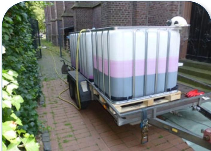
Mobile Anlage zur Einbringung des Oxidationsmittels.
