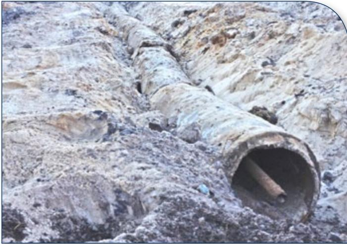
**Aufgrund von Rückschlüssen aus dem Grundwassermodell wurde wiederholt Schadensquellen – hier die Sickerrohre mit der TNT-Belastung – entdeckt.**
