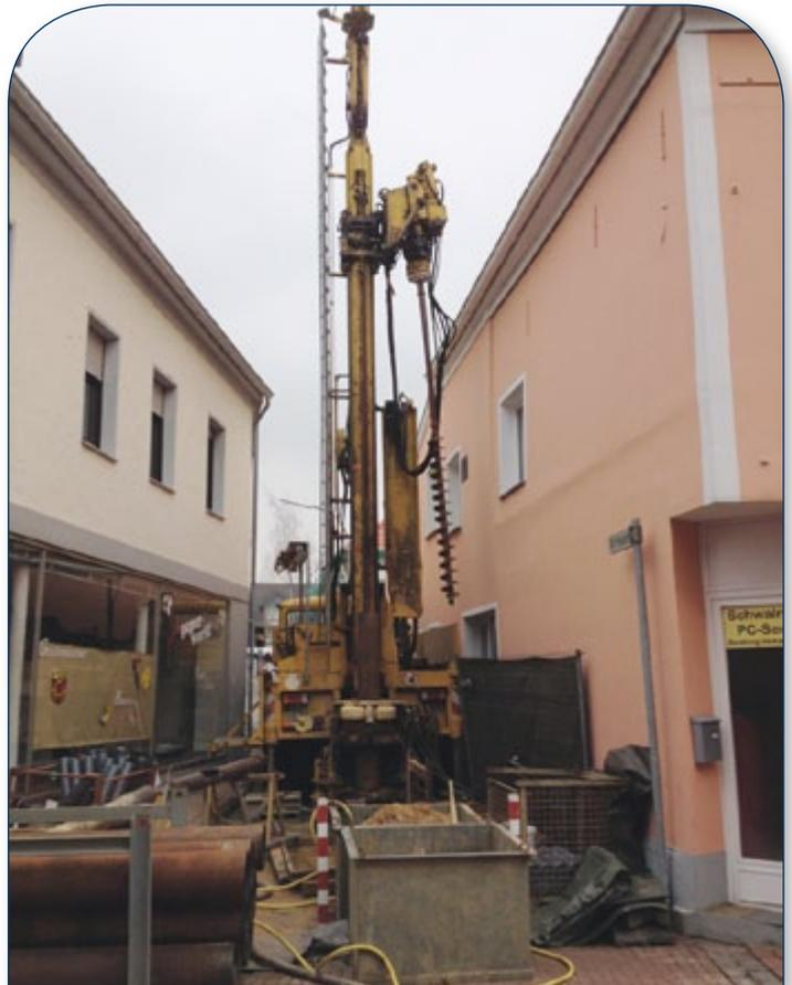
Durchführung einer Linerbohrung und Errichtung einer Grundwassermessstelle. Foto: AAV NRW
