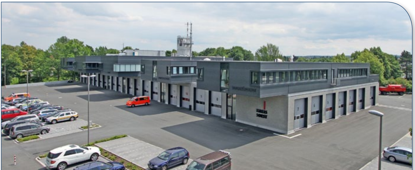
Auf der Übersichtsaufnahme des Rettungszentrums sind alle Gebäudeteile zu sehen.
