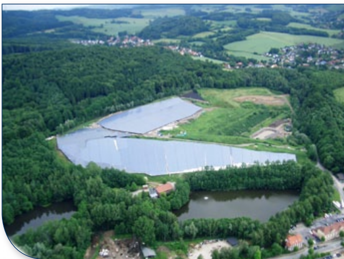
PV-Anlage auf der Deponie Dörentrup (Lippe) als Abdichtung. Leistung: 4,16 Mio. kWh.
