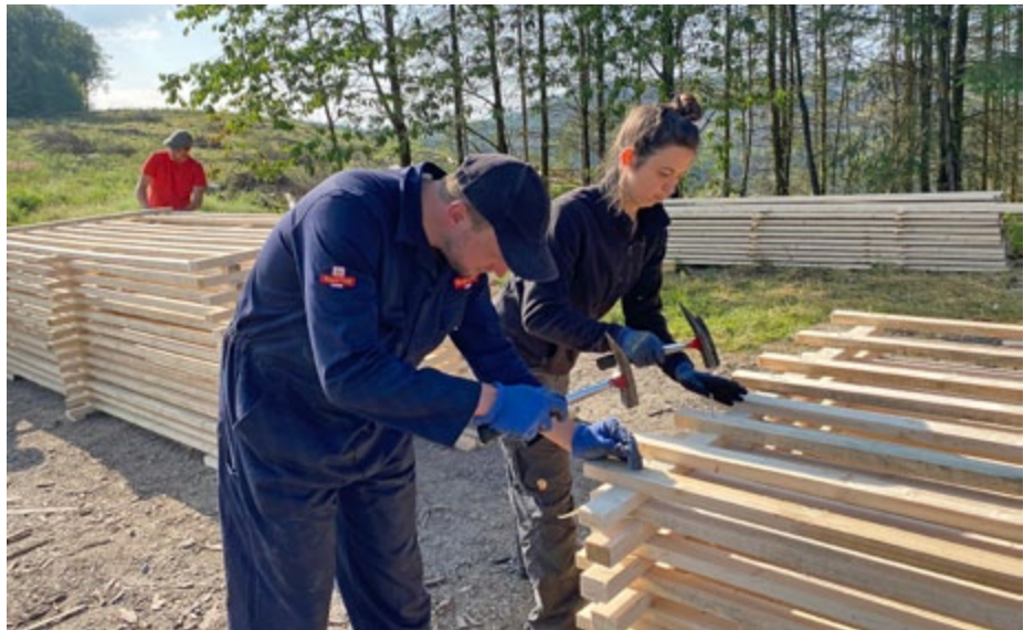
Hier werden sogenannte Hordengatter gebaut – Zäune aus Holzelementen, die Setzlinge vor Wildverbiss schützen. Quelle: Alexander Bange/Märkischer Kreis
