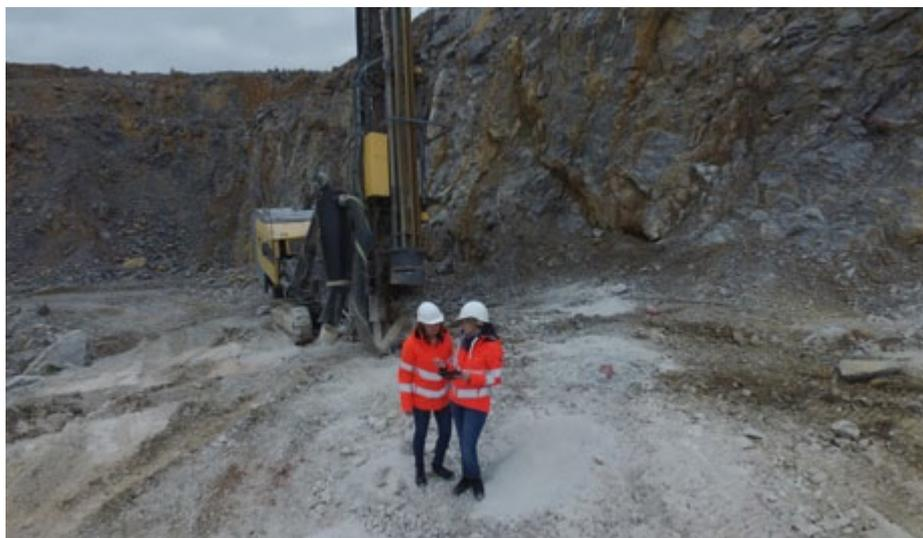
Durchführung einer Sprenganmeldung auf dem Bohrfeld mit Hilfe des GPS-Signals vom Tablet.
