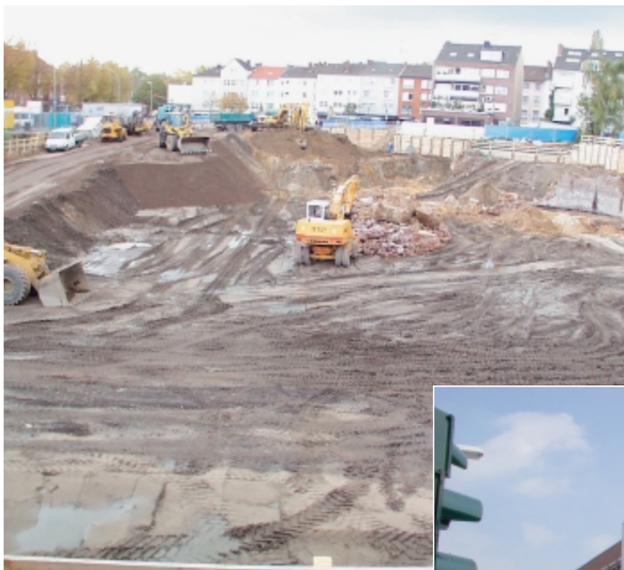
In Wesel hat sich der AAV an der Sanierung eines ehemaligen Gaswerkes beteiligt.
