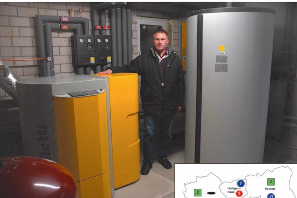
**Landwirt Kneer in Wülfrath zwischen seinem Pelletheizkessel (links) und Wärmespeicher (rechts)**
