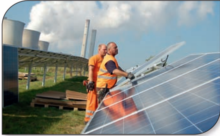
Arbeiter bei der Montage der Solarmodule. Foto: Kreis Düren
