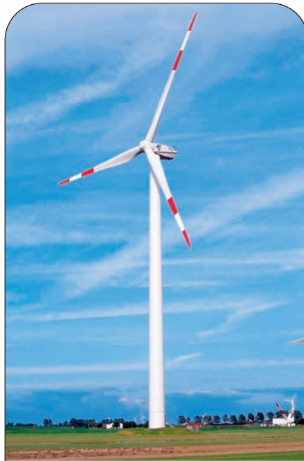
Eine der Windkraftanlagen im Kreisgebiet Heinsberg.
