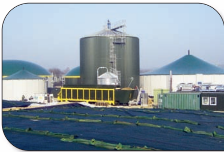
Die Biogasanlage Wassenberg versorgt ein Kombibad mit Wärme.
