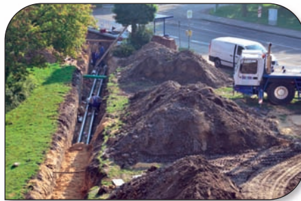
Die Verlegung der Nahwärmeleitung am Kreishaus in Heinsberg.
