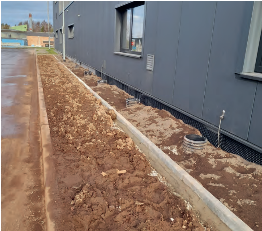
Erdarbeiten vor dunkler Fassade zur bodengebundenen Fassadenbegrünung am Abfallwirtschaftszentrum Kreis Euskirchen.
