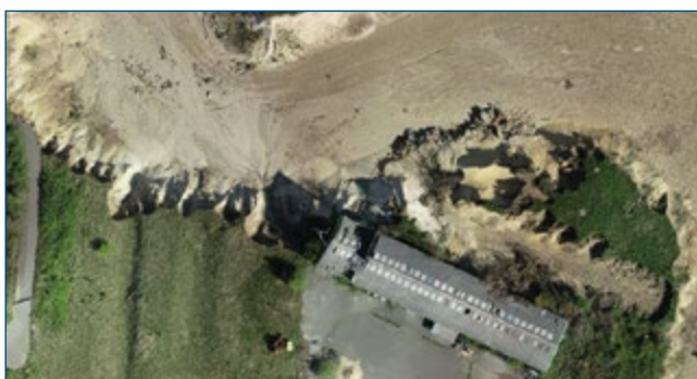
Abb.: Hochwasserschutz durch Drohnenbefliegung (Kreis Düren)
