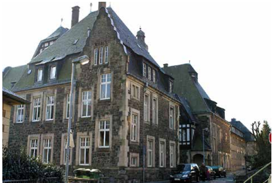
Kreishaus Altena – altes Gebäude: Im Kreishaus in Altena ist unter anderem ein Aufzug eingerichtet worden, der Menschen mit körperlichen Einschränkungen einen barrierearmen Zugang zu ihrem Arbeitsplatz ermöglicht. Quelle: Märkischer Kreis
