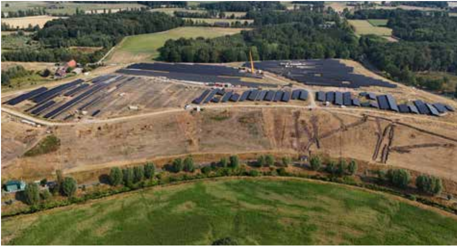
Bau der PV-Anlage auf der Deponie Borken-Hoxfeld - Stand Juli 2026.
