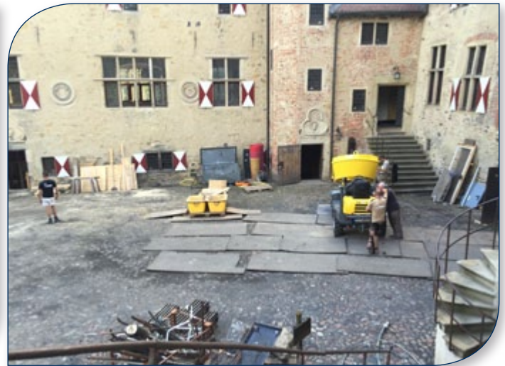
Bauarbeiten in der Burg Vischering.
