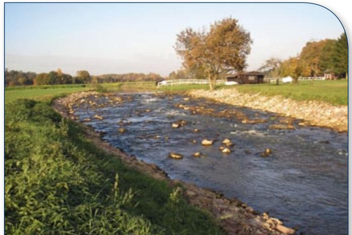
Aus dem früheren Kulturstau (linkes Foto) des Halterner Mühlenbaches entstand eine Sohleite (rechtes Foto).
