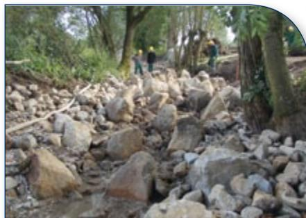
**Das Hauptstauwehr ist abgerissen worden und der Höhenunterschied wurde durch große Setzsteine mit entsprechenden Zwischenräumen abgebaut.**
