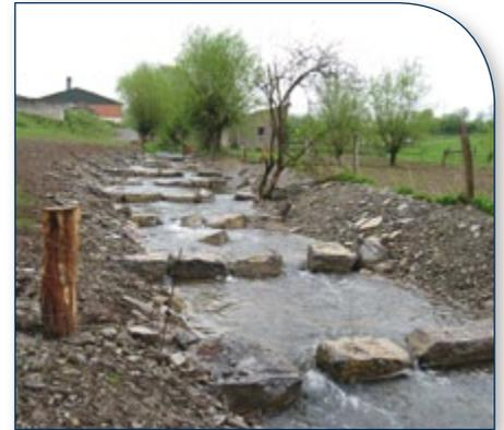
**Im Bereich des ehemaligen Bruchwehres in Bellersen gelang die Herstellung der ökologischen Durchgängigkeit durch die Anlage einer naturnahen Sohlgleite.**
