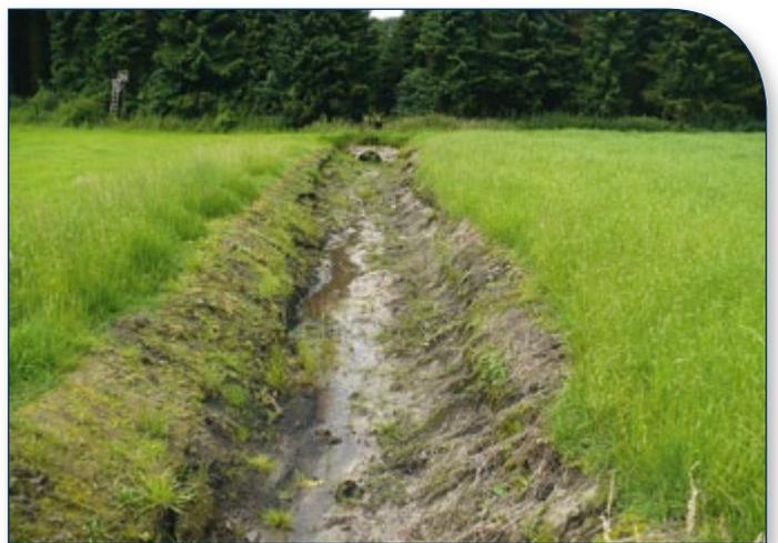
Die rund 60 Meter lange Verrohrung des Loemühlenbaches (linkes Bild) konnte aufgehoben und damit die ökologische Durchgängigkeit des Gewässers verbessert werden (rechtes Foto).
