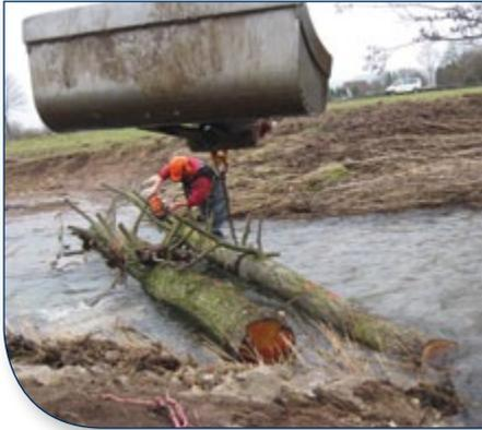
**Der Einbau von Totholz als Strömungsenker im renaturierten Abschnitt des Heubaches dient der Förderung gewässerdynamischer Prozesse.** (Bild: U. Wycisk 2011)
