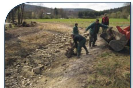
**In einen neu gestalteten Wasserlauf werden zur Strukturierung Baumstubben eingebracht.**
