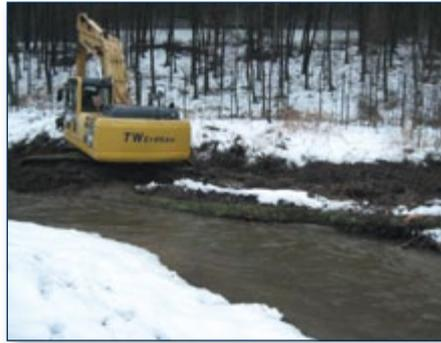
Mittels eines Baggers erfolgte der Totholzeinbau.
