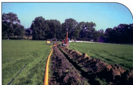
Hier wird die Biogasleitung zwischen Biogasanlage und Blockheizkraftwerk am Kreishaus verlegt.
