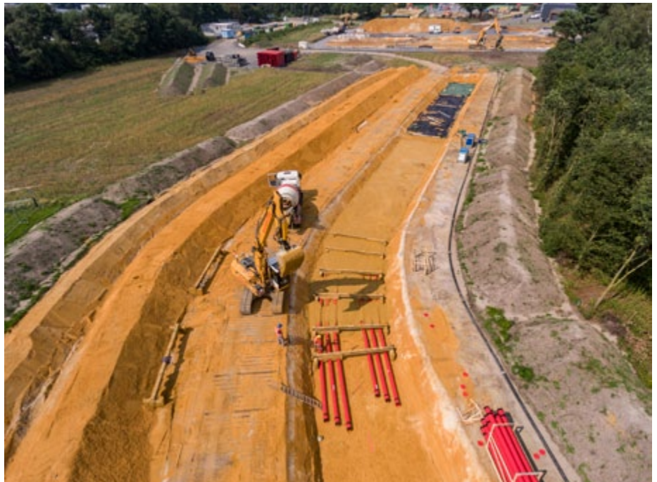
Erdkabel – Offene Bauweise.
