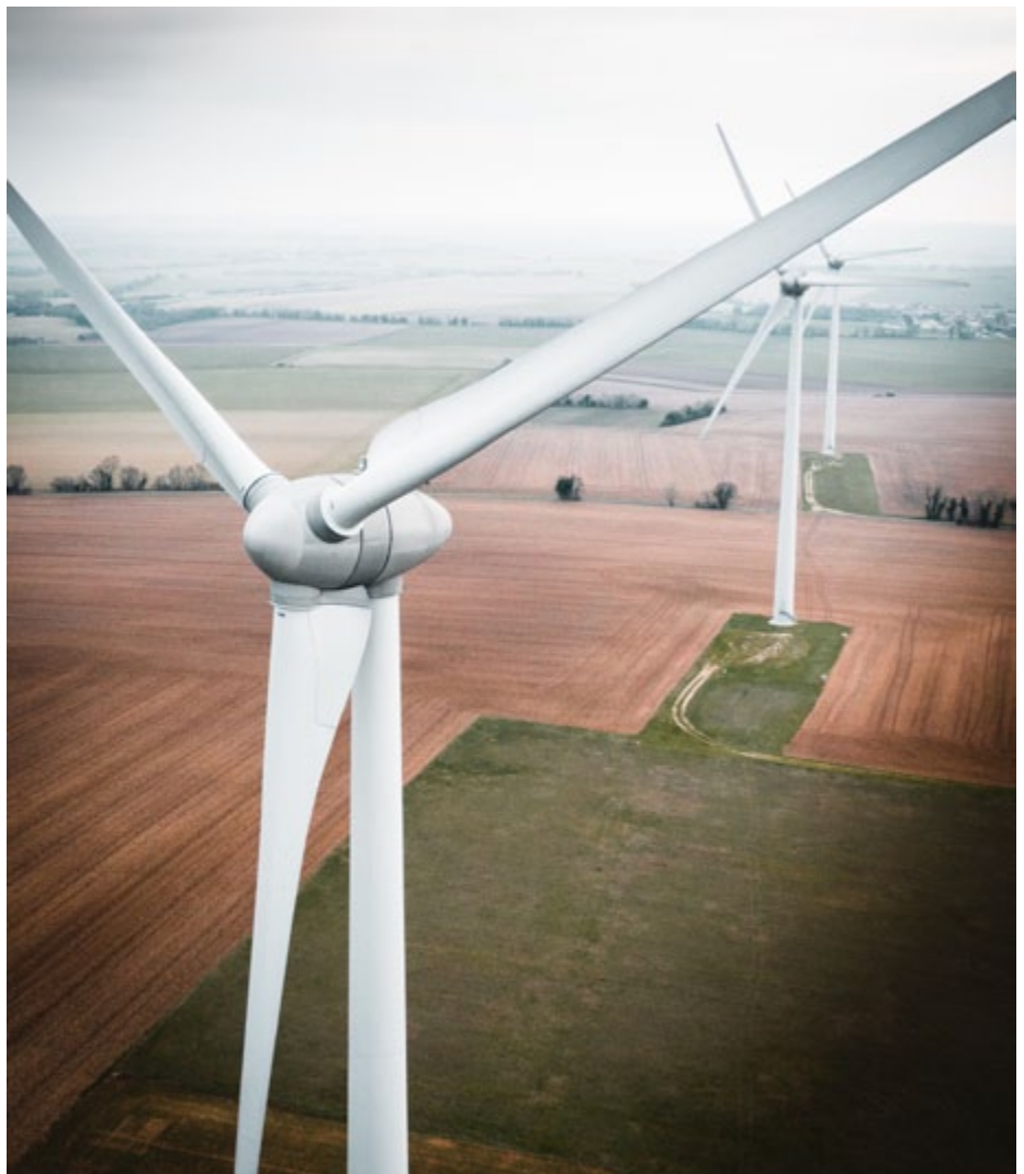
Windenergieanlagen im kreisangehörigen Raum.
