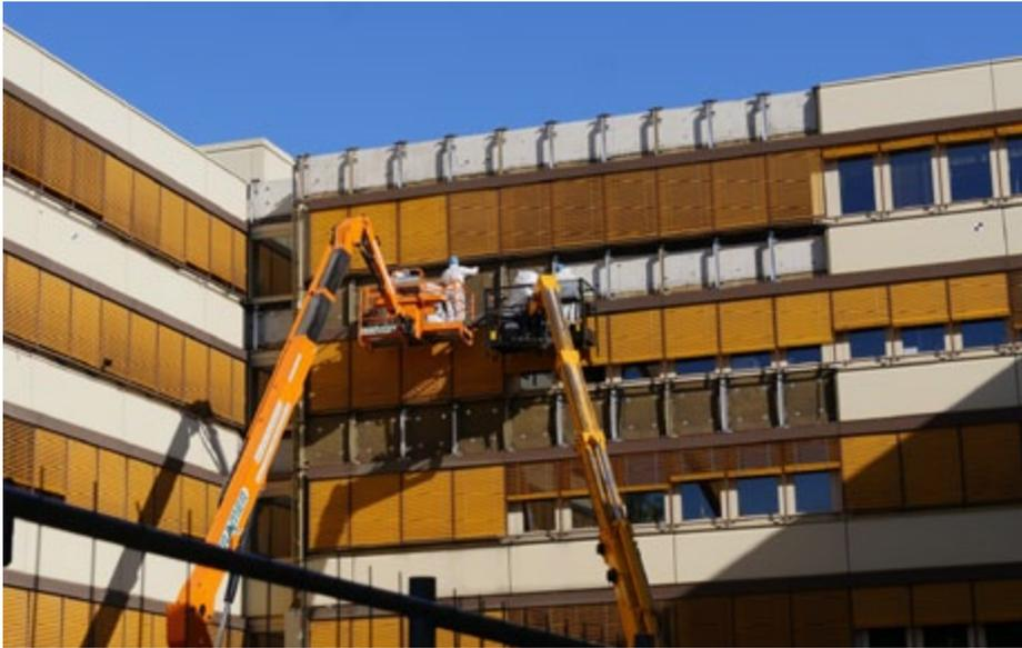
Bei laufendem Betrieb wird die Fassade saniert. Die Demontage der Bauteile erfolgt dabei mit hohen Sicherheitsvorkehrungen.
