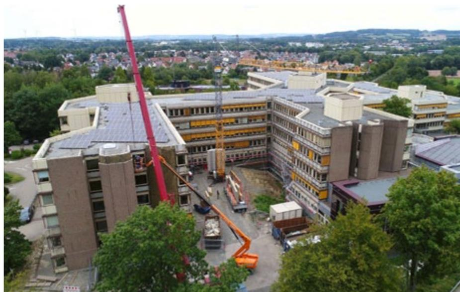
Der erste von 13 Bauabschnitten ist in vollem Gange. Die Demontage der bis zu 4,5 Tonnen schweren Waschbetonplatten (links) läuft parallel zur Montage der neuen Fassade. Der Austausch der Fenster folgt.
